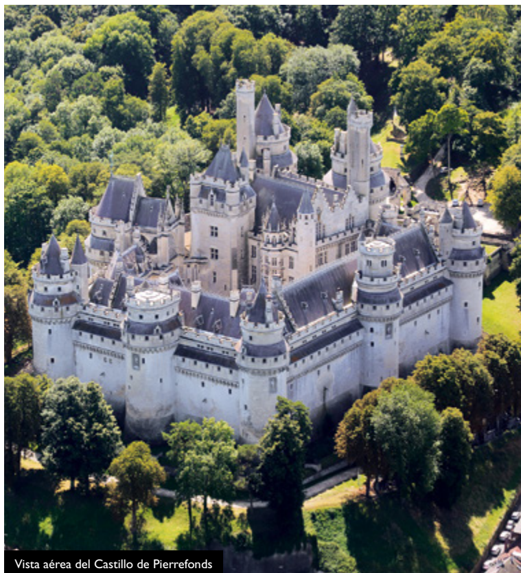
Vista aérea del Castillo de Pierrefonds
